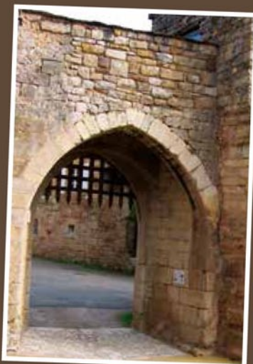
Grand portail de l'enceinte médiévale
